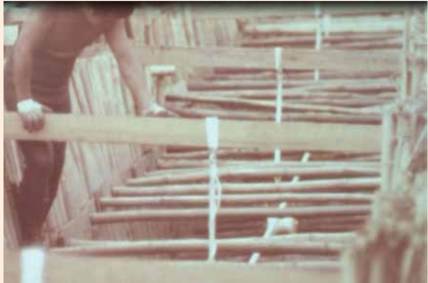
Proses Pengerjaan Pemasangan Kabel Bawah Laut Sumber : ANRI, Inventaris Arsip PT. Telkom 1966 - 2006, Arsip Audio Visual, Telkom 4
